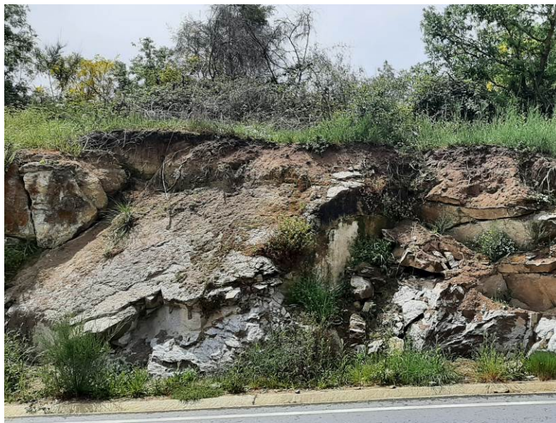
Vista frontal del desmonte de la reposición de la OU-0516 próximo al camino proyectado
