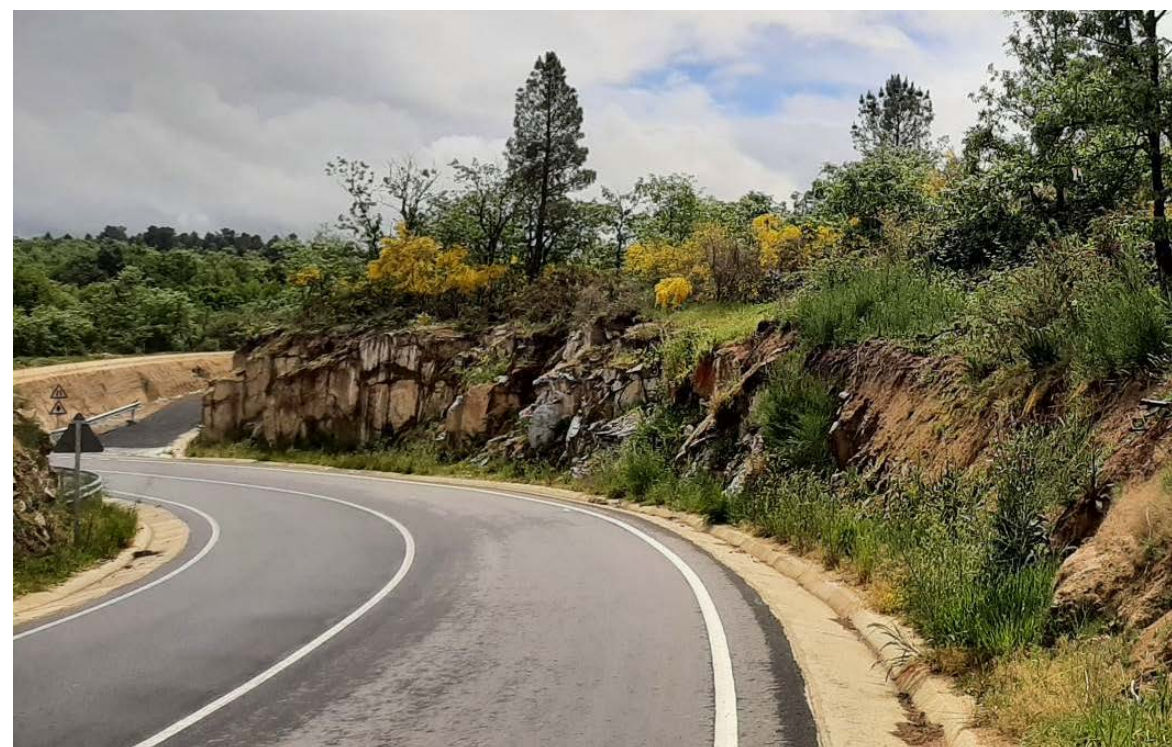
Vista de la OU-0516 hacia el paso sobre la VG-3.1. A la derecha, zona de ejecución del nuevo camino. Al fondo el acceso existente del camino de servicio
