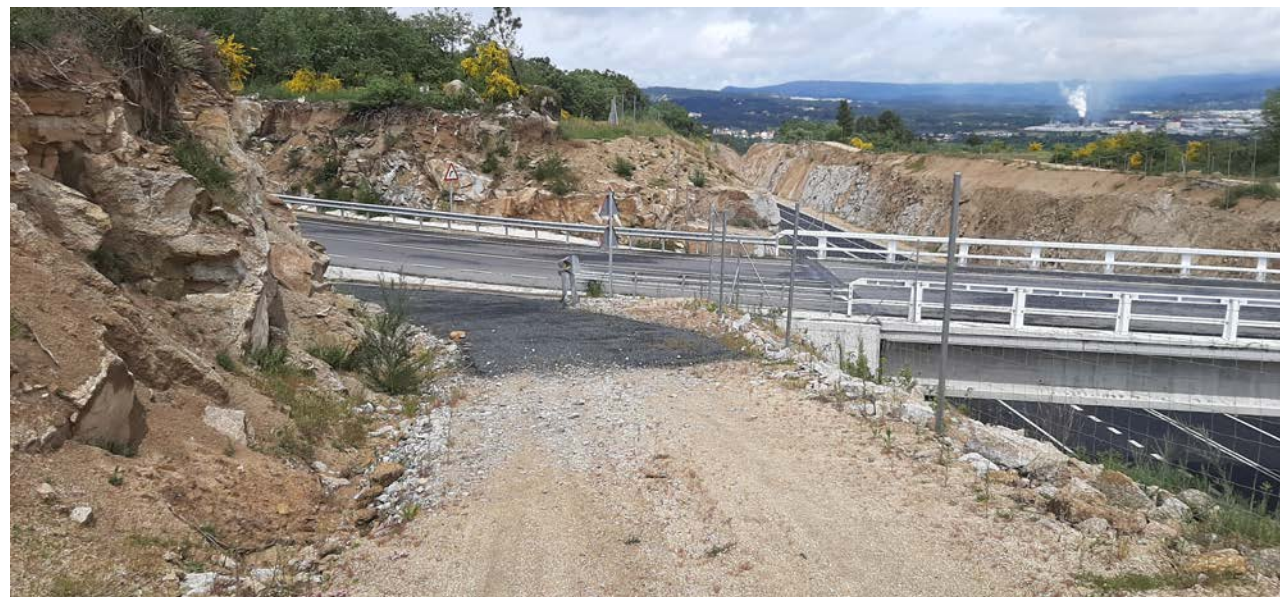
Vista do camiño de servizo no seu acceso á OU-0516 e paso sobre a VG-3.1
