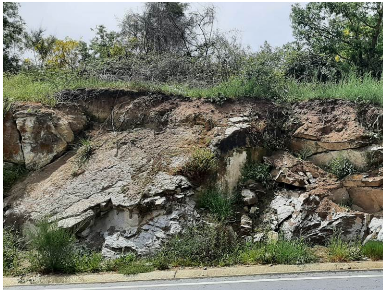
Vista frontal do desmorte da reposición da OU-0516 próximo ao camiño proxectado
