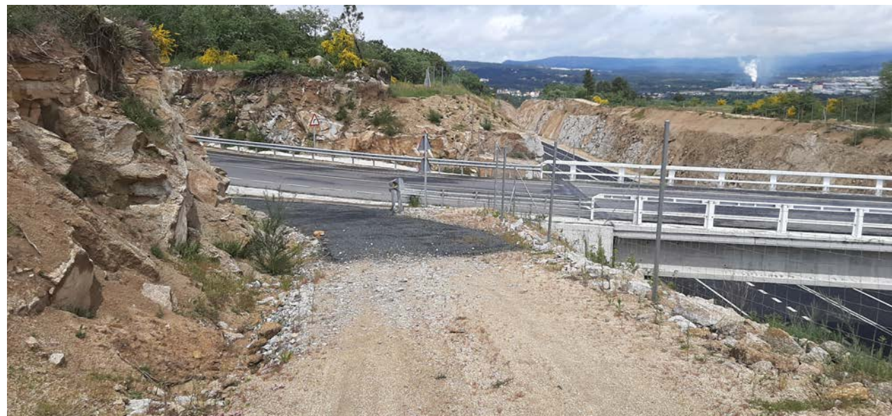
Vista del camino de servicio en su acceso a la OU-0516 y paso sobre la VG-3.1
